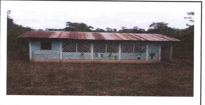
Foto 5: sustitucion de ventanas de madra por ventans de metal.
