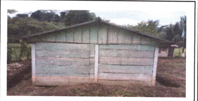
Foto 2: Sustitucion de estructura de madera por estructura de metal.
