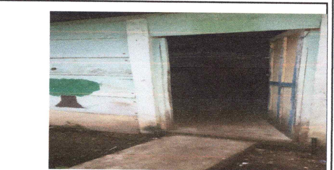
Foto 4: Sustitución de piso de concreto.
